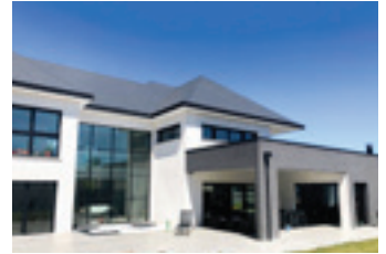
Kuća veličine 610 m 2 sa podnim grejanjem i toplom vodom u mestu Saint-Prest (Francuska)
