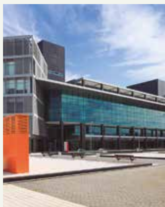
Technologiepark Andalusien in der Provinz Malaga. Bürogebäude mit hoher Energieeffizienz. Spanien. ECOi
