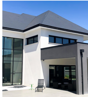
Huis van 610m 2 met vloerverwarming en DHW in Saint-Prest (Frankrijk)
