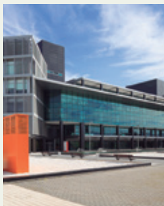
Tehnološki park u Andaluziji. Kancelarije visoke energetske efikasnosti. Španija. ECOi
