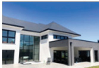
610 m2 dom s podlahovým vykurovaním a TUV v Saint-Prest (Francúzsko)
