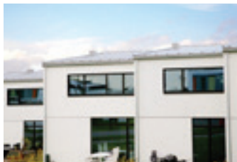
75 nízkoenergetických domov v Hasselageri (Dánsko)
