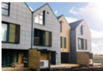
77 nízkoenergetických domov s 3 poschodiami vo Vilniuse (Lotyšsko)
