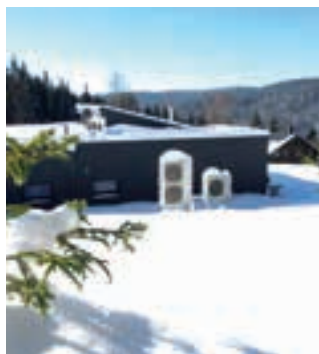
Rodinný dům v horské oblasti (nadmořská výška 750 metrů) vytápěný a chlazený tepelným čerpadlem s 300litrovým nerezovým bojlerem. Nové Hamry, Česká republika. Aquarea
