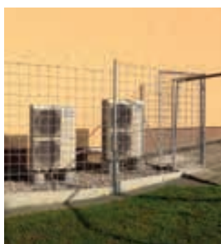
Centrální vytápění tuhými palivy pro 24 bytů předěláno na samostatné vytápění 4 bytových domů 8 tepelnými čerpadly. Sobětky, Česká republika. Aquarea
