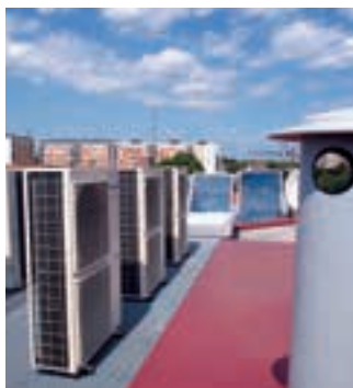
Výměna plynového systému vytápění za úspornější řešení postavené na kaskádě 8 tepelných čerpadel. Opava, Česká republika. Aquarea
