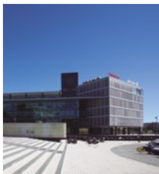
Andalucia Technology Park. Málaga, Španělsko. ECOi
