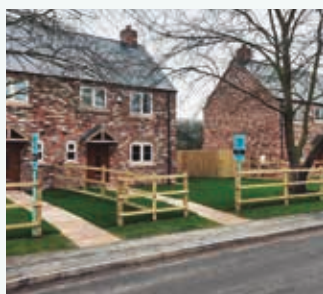
Aquarea Wärmepumpen für Heizen und Brauchwarmwasserbereitung in einem ländlichen Neubaugebiet, Großbritannien. Aquarea
