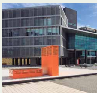
Parque Tecnológico de Andalucía Bureaux à haute efficacité énergétique, Espagne. ECOi
