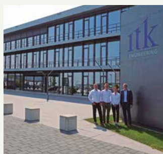
ITK Engineering GmbH. Un immeuble de bureaux innovant situé en Allemagne. ECOi - PACi
