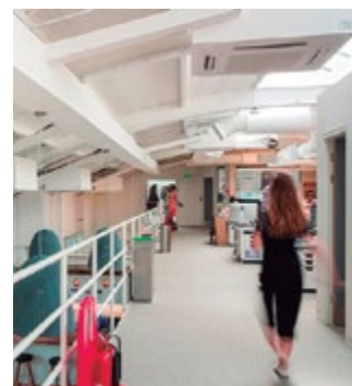
Lock Building, a Viacom médiaóriás irodái. Camden, London, Nagy-Britannia. ECOi
