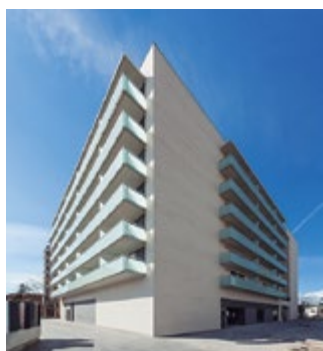
84 lakásos új építésű apartmanház a barcelonai Cornella de Llobregatban. AQUAREA
