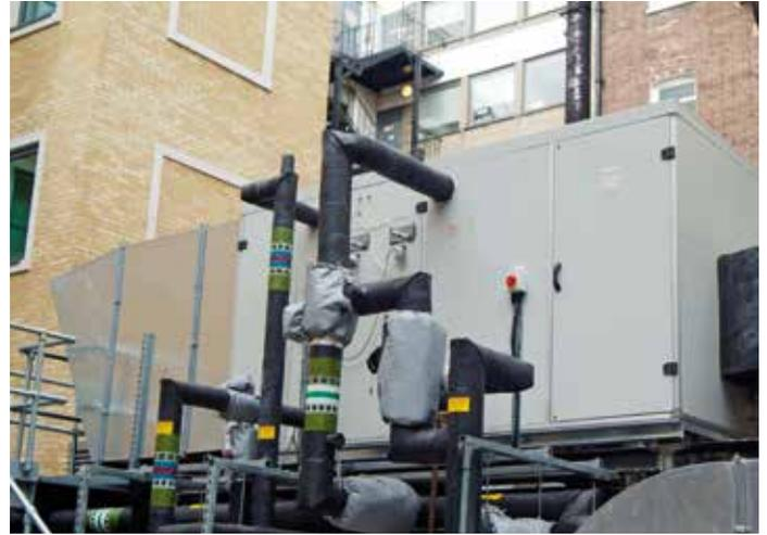
**COLLEGAMENTO DI UNITÀ DI VENTILAZIONE AD ACQUA FREDDA IN UN SISTEMA DI CLIMATIZZAZIONE.
