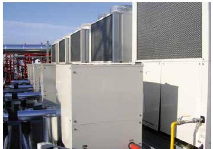
**SOSTITUZIONE DI UN IMPIANTO DI REFRIGERAZIONE CON UNITÀ DI VENTILAZIONE AD ACQUA FREDDA.
