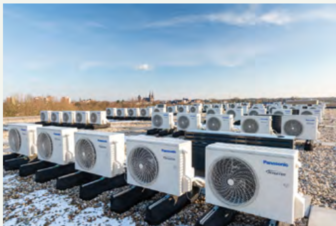
75 Warmtepompen appartementen Cuijk. Aquarea All in One
