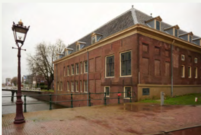
Marine Base Amsterdam. Volledige efficiënte oplossing voor koeling. Chillers
