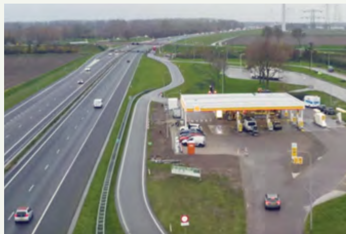
Warmtepomp bij Shell tankstation Buttervliet. ECOi W
