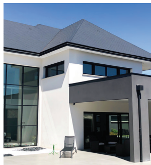
610 m 2 hus med gulvvarme og tappevarmtvann i Saint-Prest (Frankrike)
