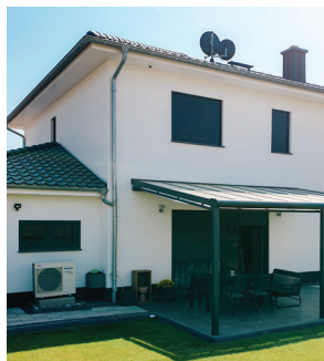
Nytt hus i Erlensee nær Frankfurt am Main (Tyskland)
