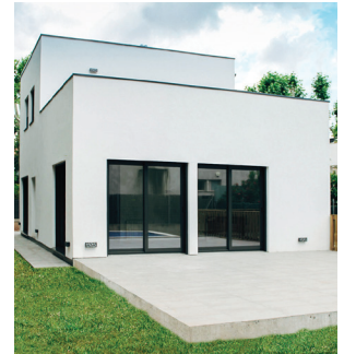
Nytt passivhus i Sant Cugat del Vallès (Spania)
