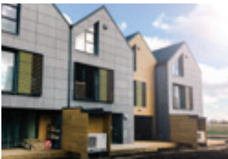
77 3-nadstropnih nizkoenergijskih hiš v Vīlni (Latvija)
