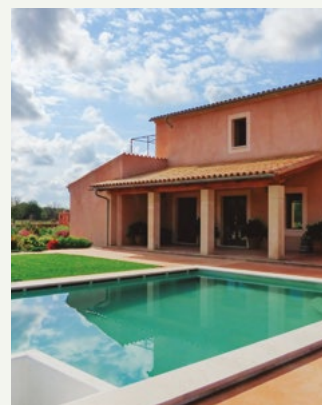
Vivienda unifamiliar pasiva "Proyecto Tierra" en Lluçmajor, Mallorca, España. Aquarea
