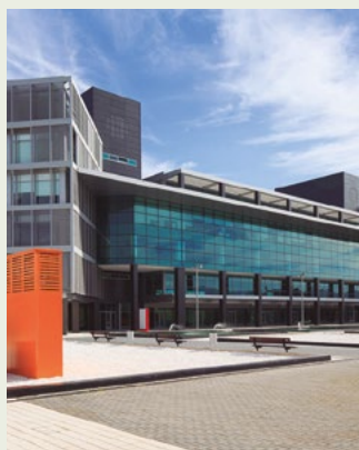
Parque tecnológico de Andalucía. Oficinas de alta eficiencia energética. España. ECOi
