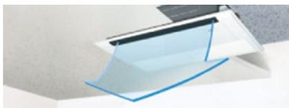
**1. Sistema unidireccional de «impulsión hacia abajo».**
