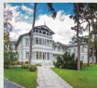
Gurewicz Spa Resort. Hotel - Ristorante - Spa. Otwock, Polonia. PACi, VRF e comando.
