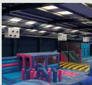
AirHop. Parco ricreativo al coperto. Gloucester, Regno Unito. PACi e Jet Air Stream.
