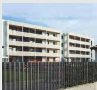
Cross Light House. Edificio residenziale. Mulazzano, Italia. PACi e nanoe™ X.
