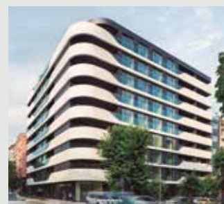
Varna Wave. Edificio residenziale. Varna, Bulgaria. Aquarea e app Panasonic Comfort Cloud.
