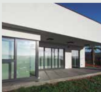
Passivhaus a Miño. Casa passiva residenziale. Miño, Spagna. Aquarea.
