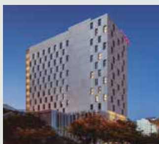
Hotel Moxy Oriente. Hotel. Lisbona, Portogallo. PACi, VRF e comando.
