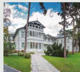
Gurewicz Spa Resort. Hotel - Ristorante - Spa. Otwock, Polonia. PACi, VRF e comando.
