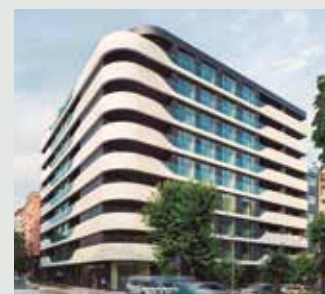
Varna Wave. Edificio residenziale. Varna, Bulgaria. Aquarea e app Panasonic Comfort Cloud.
