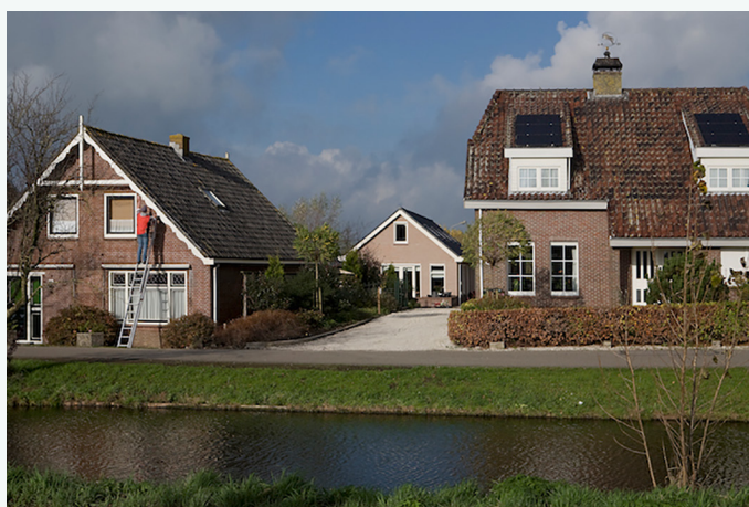
Derko Installatietechniek heeft ervaring met warmtepomp plaatsen in eigen woning. Aquarea
