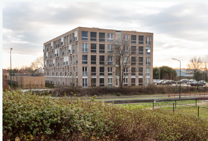
75 Warmtepompen appartementen Cuijk. Aquarea All in One
