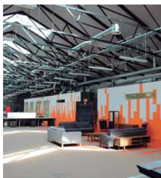
Løsningen for Zalando's kontor i en ombygd lagerbygning ved Grand Canal Quay, Dublin. ECOi
