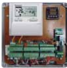
LBA-kontroll. Styrekort, strømtransformator, koblingsplint
