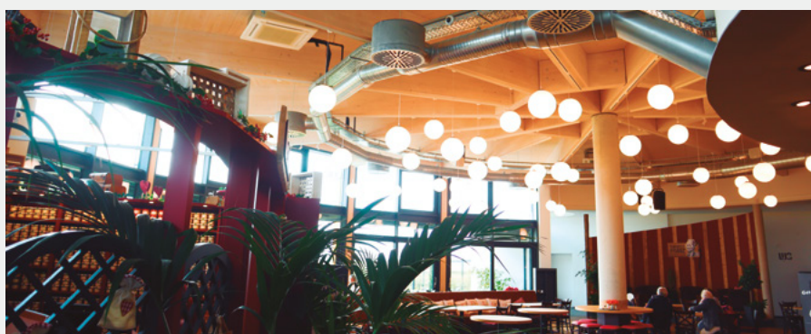
Weinbuch slakterbutikk. Butikk og restaurant. Öpfingen, Tyskland. VRF, husholdning og kjøling
