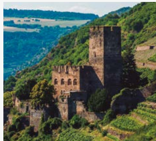
Gutenfels. Hotell. Kaub, Tyskland. Aquarea og Aquarea Smart Cloud.
