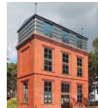
Wieża ciśnieni przebudowana na oryginalny dom jednorodzinny w Yorkshire, Wielka Brytania. AQUAREA
