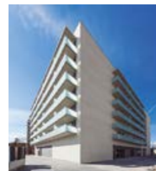
Nowy budynek z 84 mieszkaniami w Cornella de Llobregat w Barcelonie. AQUAREA
