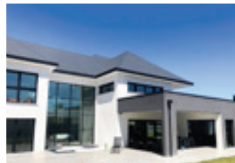
Casă cu o suprafață de 610m 2 cu încălzire prin pardoseală și apă caldă menajeră în Saint-Prest (Franța)
