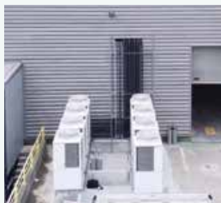
STEMCELL Technologies, svetovno biotehnoško podjetje, je namestilo kondenzacijske enote CO 2 v hladilnice v skladišču. Francija Hlajenje
