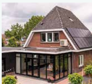
Aquarea T-CAP zagotavlja popolno rešitev za ogrevanje, hlajenje in sanitarno toplo vodo pri prenovi razkošne hiše v kraju Voorthuizen na Nizozemskem. Aquarea
